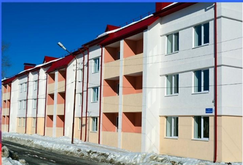
г. Североуральск, ул. Комсомольская, 33
